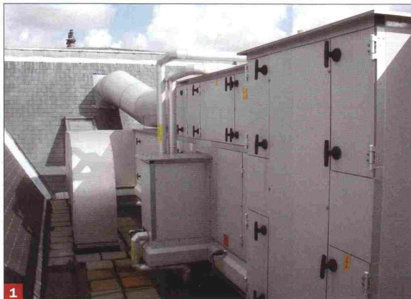
De luchtbehandelingskast is op het dak geplaatst
