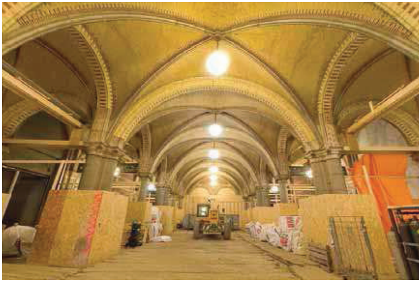
Het Rijksmuseum Amsterdam wordt momenteel grondig verbouwd.
