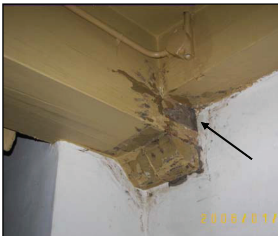
Figuur 4 Afbeelding van een met behulp van epoxyhars gerestaureerde balkkop in een 17 de eeuws grachtenpand waar luchtbevochtiging wordt toegepast. Waarschijnlijk ten gevolge van inwendige condensatie in de buitenwand, is er rotting opgetreden aan de balkkop.
